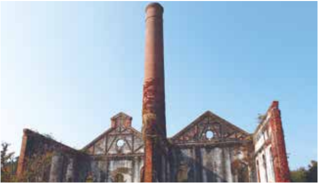
岡山県岡山市犬島の発電所跡
